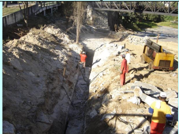
Figura 14- Corte feito por lança térmica em rochas migmatíticas do embasamento na Ponte de Ferro para canalização do esgoto no ano de 2007. Pontilhão de Ferro, Formiga- MG
